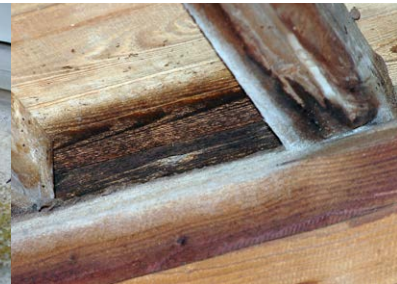
Fledermauskot auf einer Fensterbank und Verfärbung an Dachbalken (Quelle: H. Körber)
